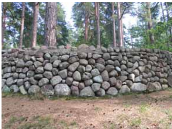
Runt begravningsplatsen finns en mur av fältsten. (KI Rälla begravningsp 010)
