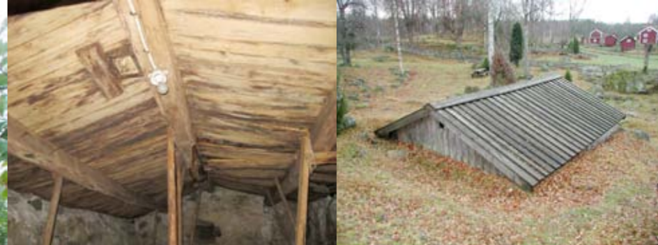
Åstak med ventilationstrumma i trä.
